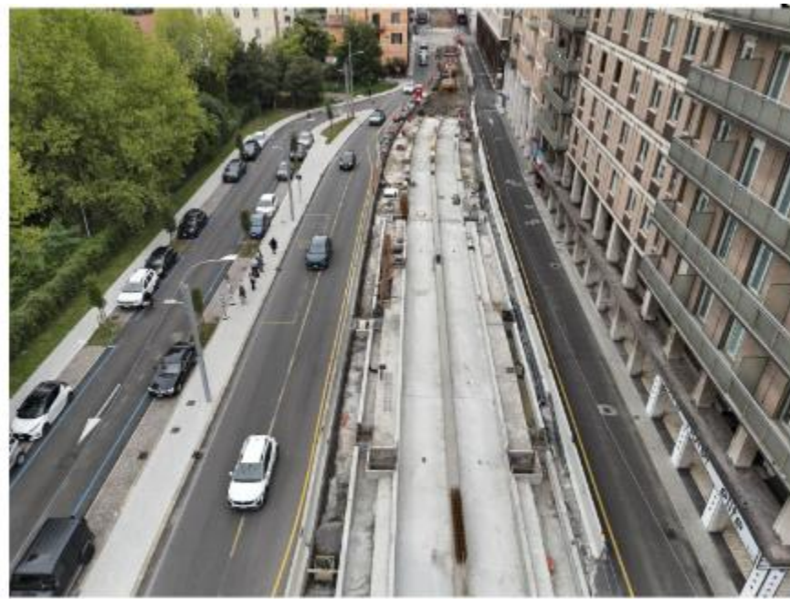
Cantiere B14 via Saffi (tra Piave/Timavo e Vittorio Veneto) Apertura viabilità definitiva entro fine dicembre 2024
