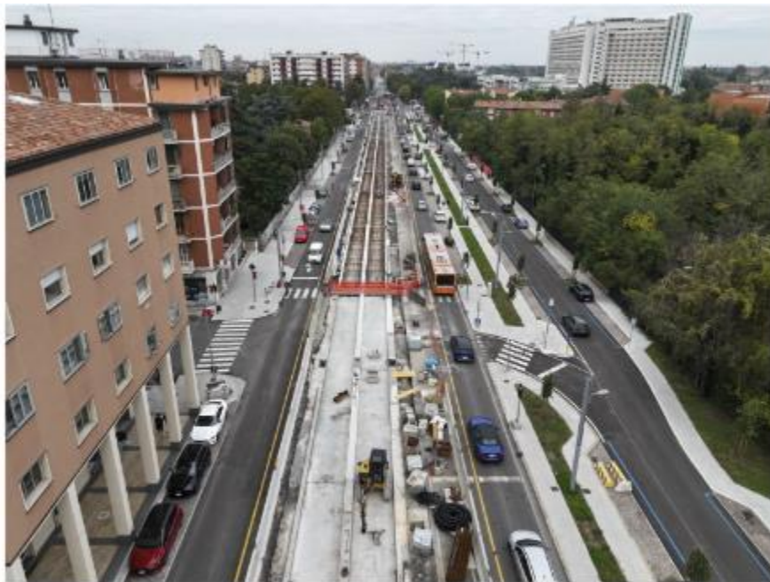
Cantiere B13 via Saffi (tra Marzabotto e Piave/Timavo) Apertura viabilità definitiva entro fine novembre 2024
